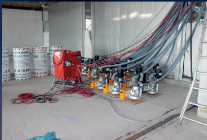
Pumpenauslagerung bei Trocknung im laufendem Betrieb
