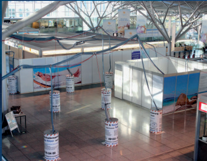
Komplexe Trocknungsmaßnahme (Flughafen)
