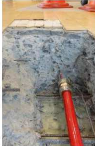
Abb. Querschnitt / Bodenkonstruktion Halle
